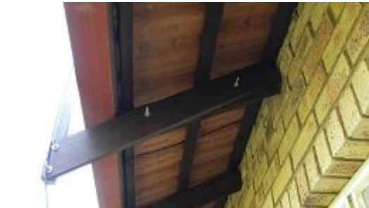
11 m Banda J-Pole antenna: staffa capriata del tetto
